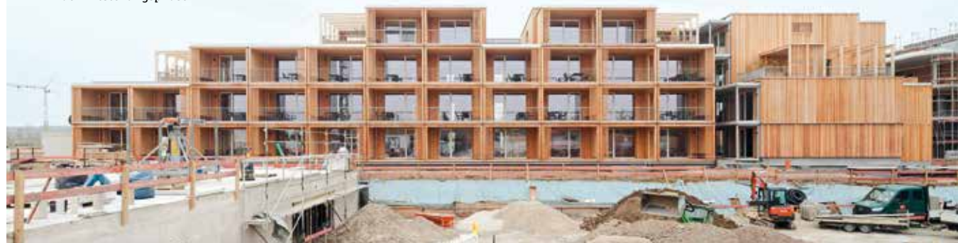
Das Mikro-Apartmenthaus Cube 68 in der Entstehungsphase
