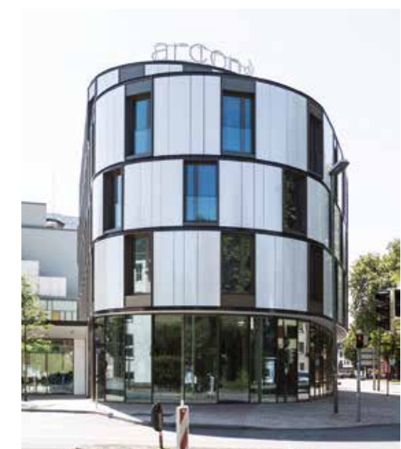
Hotel an der Osnabrück-Halle in Georgsmarienhütte: Alucobond-Kassetten, rundgezogenes Gesimsband
