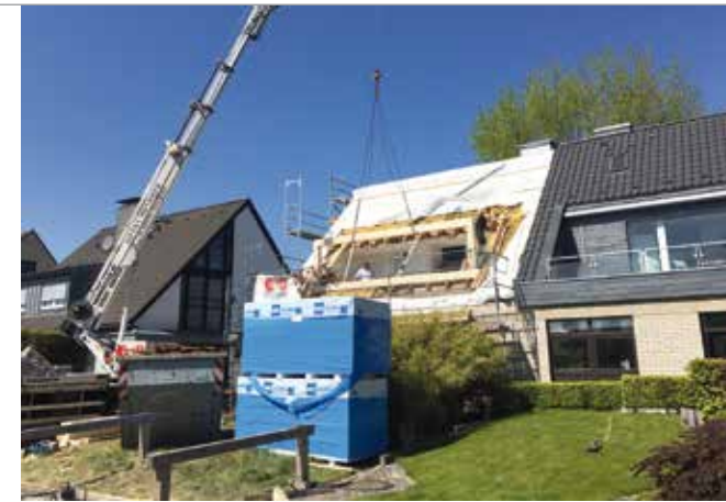
Dachgeschossausbau für einen Privatkunden.
