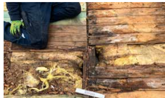
So sah die Unterkonstruktion vor der Sanierung aus.
