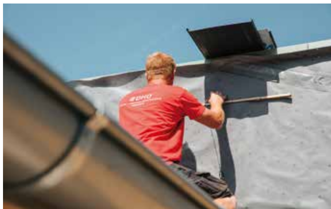
Aufmaß für die Stehfalz-Verkleidung
