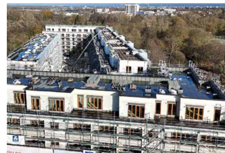
Aktuelle Großbaustelle in der Kölner Innenstadt mit Abdichtungen und Dämmung, Abdeckungen aus Aluminium, Terrassenplatten, PV-Anlagen und Dachbegrünung.
