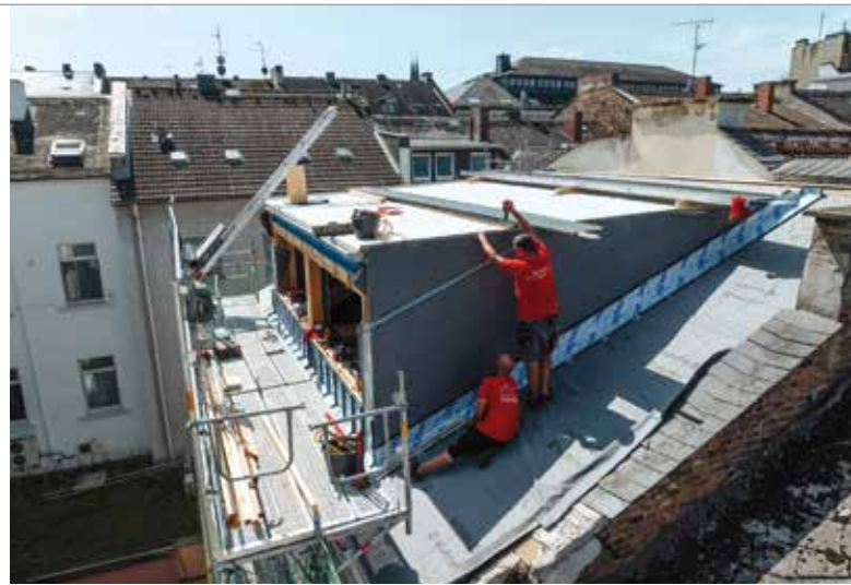
Das neue, weit größere Dachgeschoss nimmt Gestalt an.
