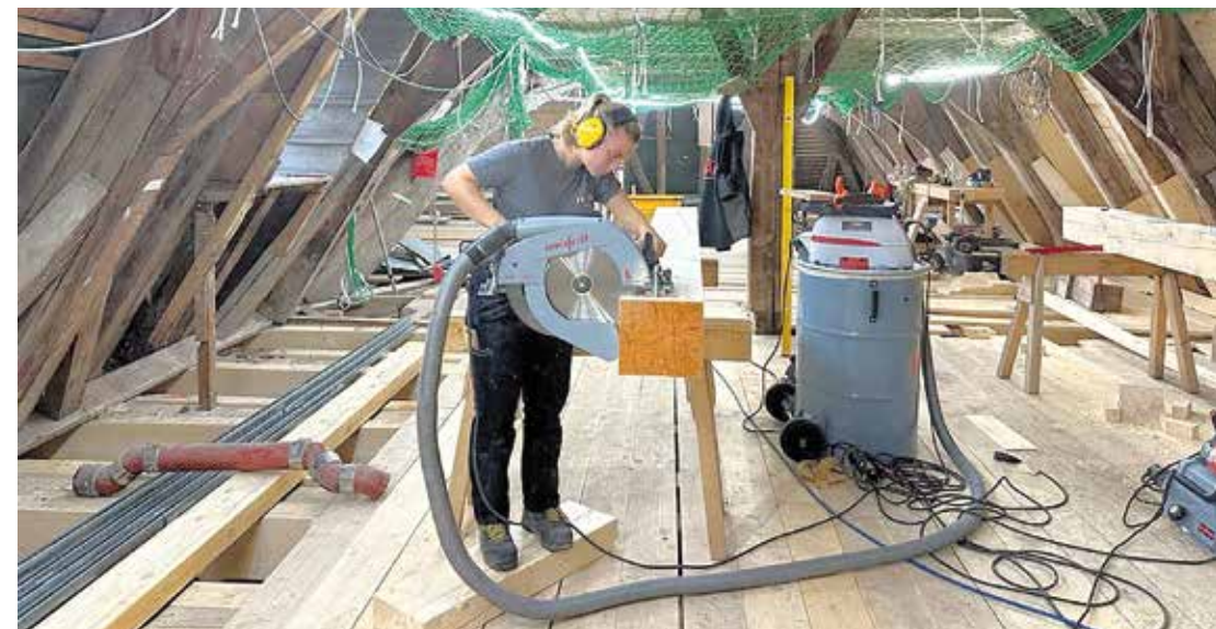
Sanierung des Dachstuhls vom Domberg in Freising. Theresa Damm bindet mit einer 130er Handkreissäge einen neuen Balken ab, der einen maroden ersetzen wird.
