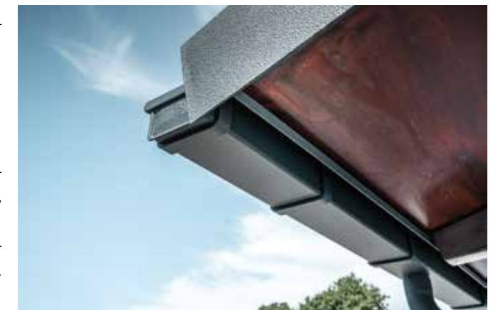
Schönes Detail: die vorgehängte, kastenförmige Dachrinne aus Aluminium.
