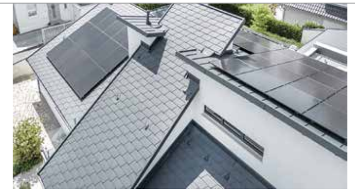
Die Verschneidungen der Dachflächen boten eine echte Herausforderung für das Sindermann-Team.
