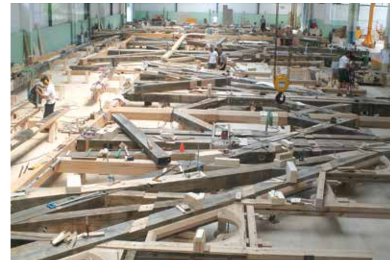
Auf Abbundböcken liegen die Balken für den Abbund über dem 1:1 Aufriss des Spitzturmes.
