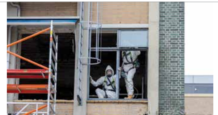
Die Dachdecker sind in der Pflicht, wenn es darum geht die Mitarbeiter zu schützen.
