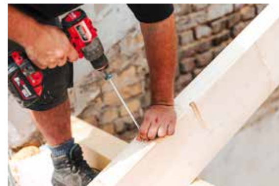
Die Holzbalken werden verschraubt.
