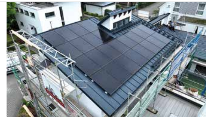
Eine PV-Anlage ist Bestandteil der neuen Dachlandschaft.
