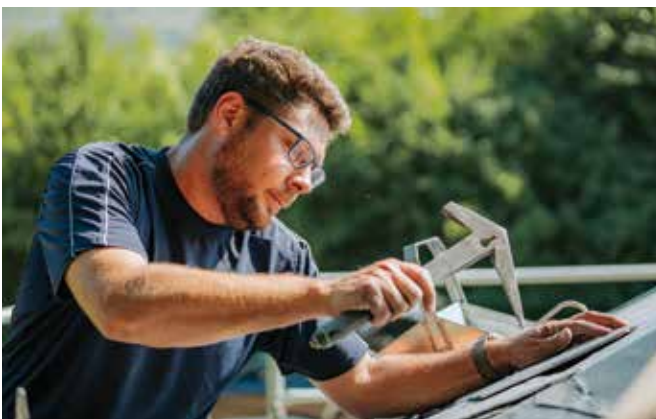
Freut sich über die vielen, herausfordernden Projekte für sein Team: Dachdeckermeister Markus Berg.
