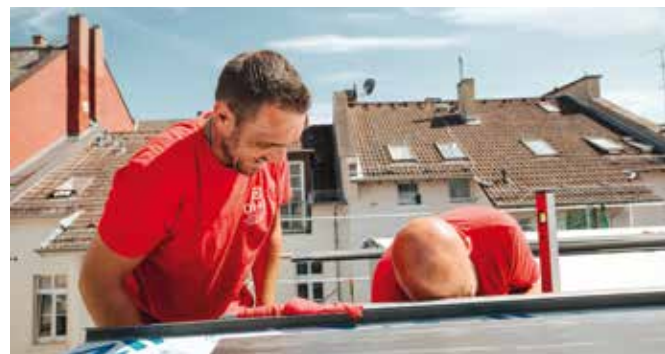
Abschließende Arbeiten oben am neuen Flachdach.
