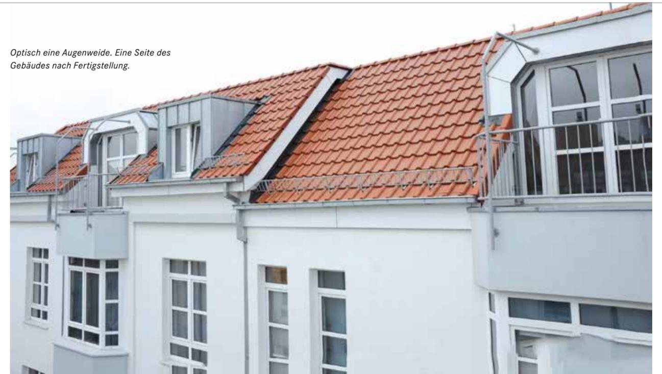
der Erstellung des Angebots und passgenauer Lieferung des kompletten Materials auf die Baustelle. Dazu gehörten das Dämmmaterial, die Bitumen- und Unterspannbahnen sowie das Metall von Rheinzink für die Gauben und der Flachdachziegel F12 Ü von Nelskamp, der sich an den Seiten unterhalb des Flachdaches anschließt. Seit über 25 Jahren ist Michael Heldt zudem auch als Privatperson Mitglied der DENW.
