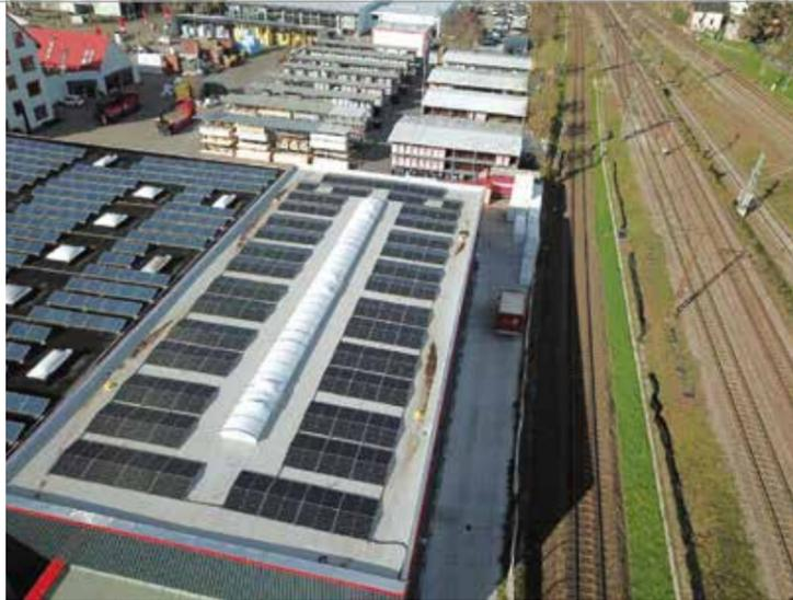
PV-Anlage mit 70 kWp Leistung für eine Lagerhalle der DE Süd Niederlassung in Mannheim.
