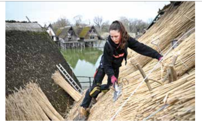
Pfahlbaumuseum Unteruhldingen: Neueindeckung der von Stürmen zerstörten Reetdächer.
