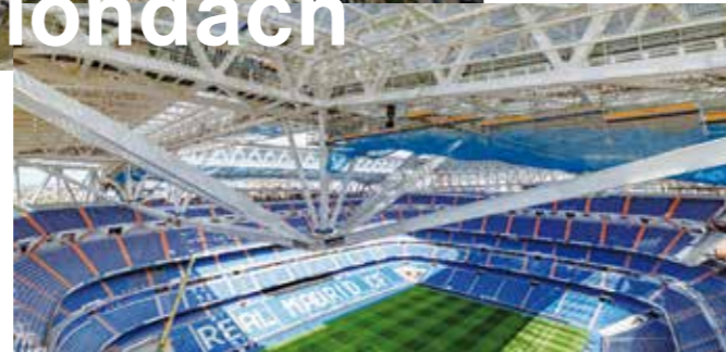
Von unten sieht man, wie mächtig diese Dachkonstruktion ist. Da braucht es das entsprechende Know-how.
