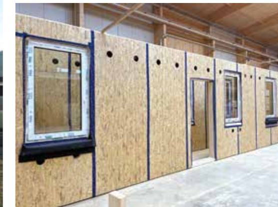
Holzmodulwände mit bereits integrierten Fenstern aus der eigenen Vorfertigung.
