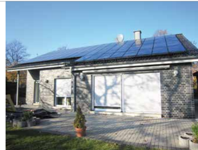
Klassisches PV-Geschäft: ein privates Einfamilienhaus.
