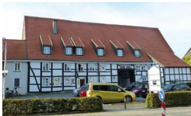
Der Betrieb hat das Steildach mitsamt Gauben des Fachwerkgebäudes und Baudenkmal Reginenstraße 16 in Hamm, erbaut in der Mitte des 19. Jahrhunderts, energetisch saniert.
