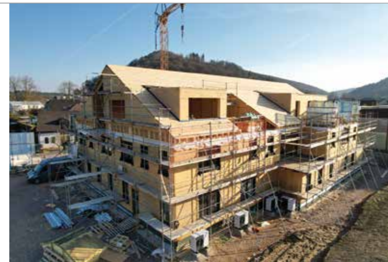
Ein Holzbauprojekt made by Holzbau Dawen.
