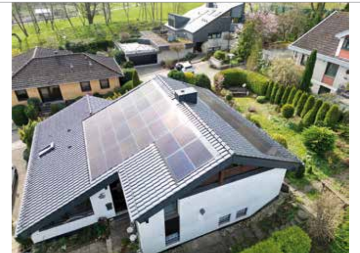
Privatkundengeschäft heute: Dachsanierung mit Indach-PV
