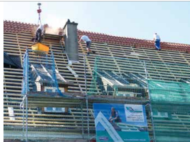
Der Betrieb hat das Steildach mitsamt Gauben des Fachwerkgebäudes und Baudenkmal Reginenstraße 16 in Hamm, erbaut in der Mitte des 19. Jahrhunderts, energetisch saniert.
