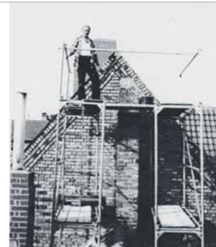
Mit Gerüsten wird schon länger gearbeitet.
