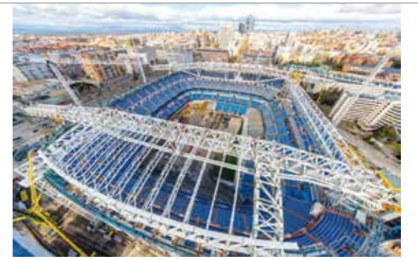
Ein Blick hinein in die königliche Arena, auch im Innenbereich eine komplette Baustelle.
