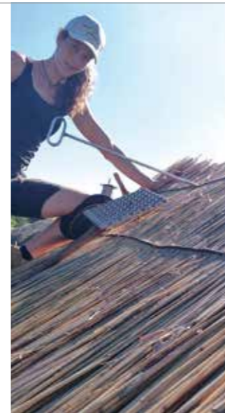
Statt der üblichen geraden und runden Nadel der Reetdachtechnik nutzt Moira Memmhardt eine seltene, speziell geformte Nadel.
