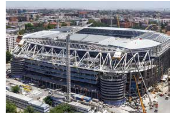
Langsam nimmt die Dachkonstruktion mit den Aluminiumprofilen Gestalt an.
